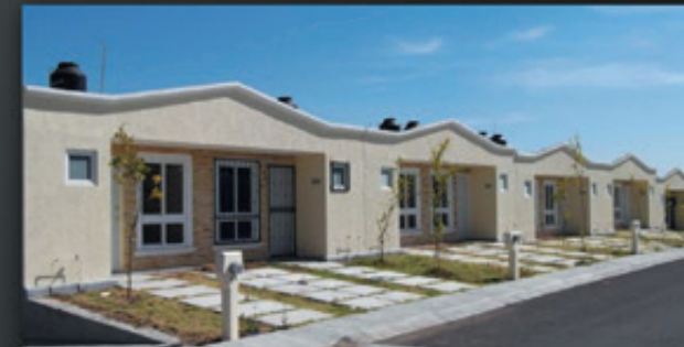
Conjunto habitacional «La Hacienda». Morelia Michoacán
