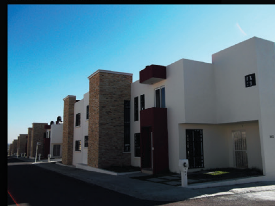
Conjunto Habitacional «La Hacienda». Morelia Michoacán
